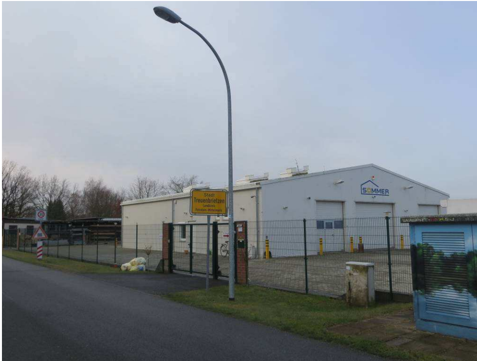
Zufahrt von Hans-Grade-Weg zum Gewerbegebiet an der B 102
