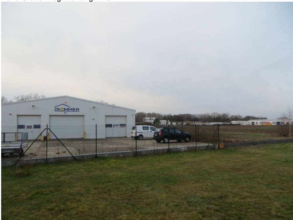
Plangebiet aus Richtung B 102
