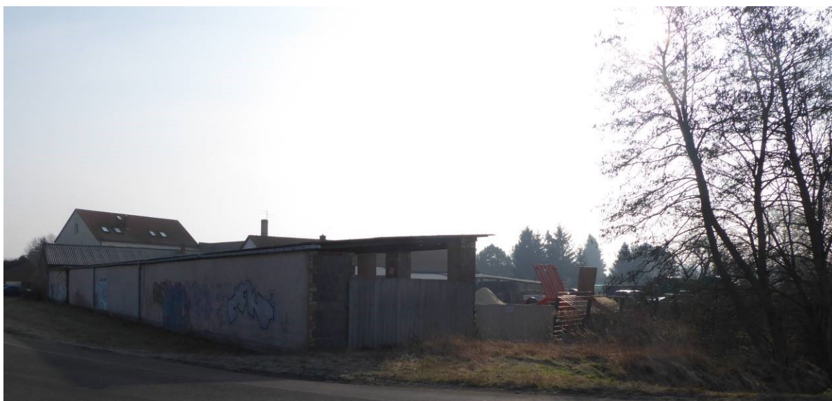
Abb. 8: Foto vom Plangebiet (Quelle: Bruckbauer & Hennen GmbH)
